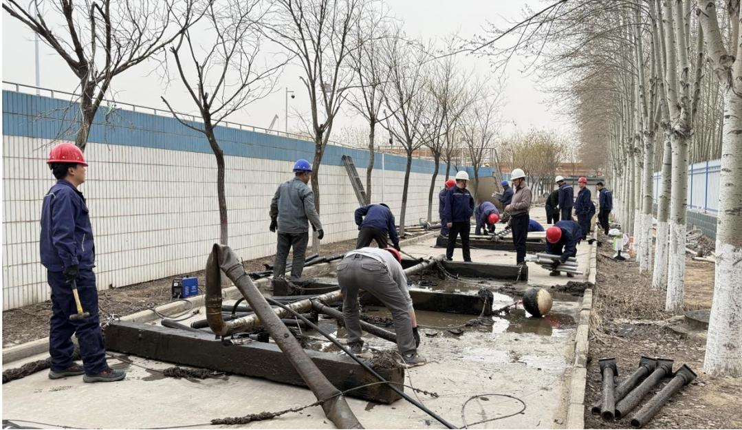
此次维修工作，提升了氧化沟曝气的均匀性和氧转移效率，可进一步提高生产效益，保证出水水质达标排放，从而实现“治理污水、节能减排、改善环境”的总体目标。
