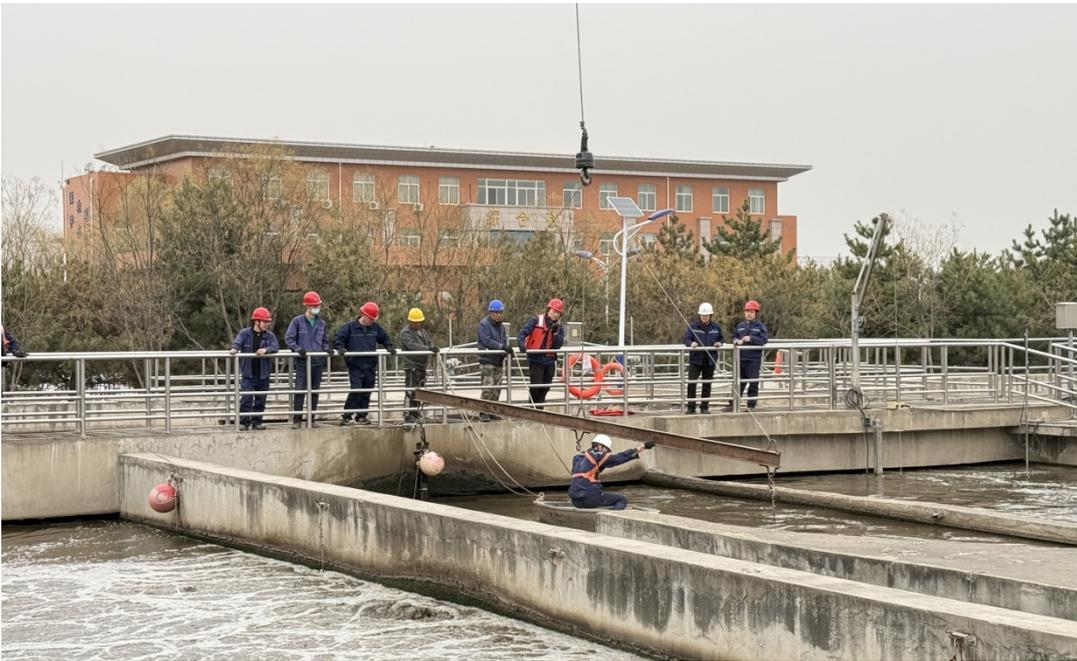
氧化沟工艺是公司污水处理的核心工艺，氧化沟的正常稳定运行关系着公司出水能否达标。为确保此次维修安全、快速完成，尽量减少维修期间曝气不足对工艺系统的影响，公司组织员工加班加点进行维修。在维修人员的紧张劳作和密切配合下，于3月26日顺利完成维修工作。经统计，此次维修曝气排共计8组，并更换配套吊装钢丝绳，目前曝气排曝气情况良好。
